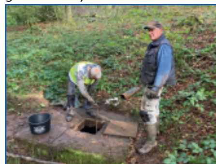
Travaux d'entretien de l'eau des Fontaines
