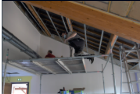
Travaux de peinture à l'école
