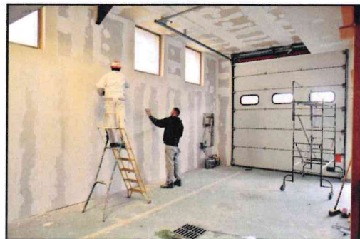
Réfection du local incendie
